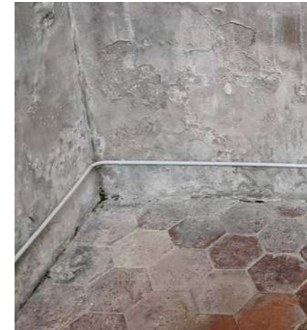
Tomette hexagonale - altération par contamination de sel
