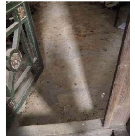
Dallage en pierre rejointoyé au ciment
