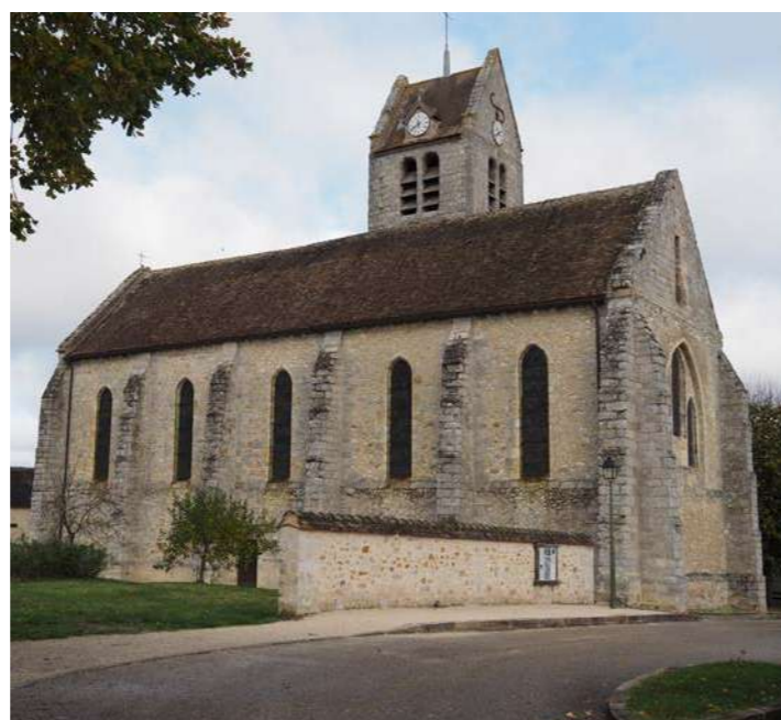
Photographie - Façade sud
