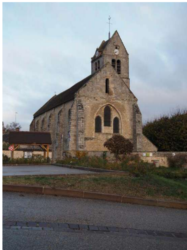
Photographie - Façade est
