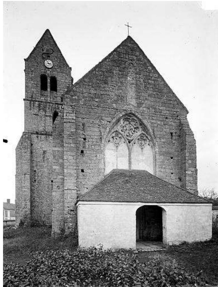
Photo de l'église Saint-Étienne - Façade Ouest - Les baies du clocher sont partiellement murées - La baie d'axe est murée partiellement - Un porche a été construit à l'avant du portail occidental
