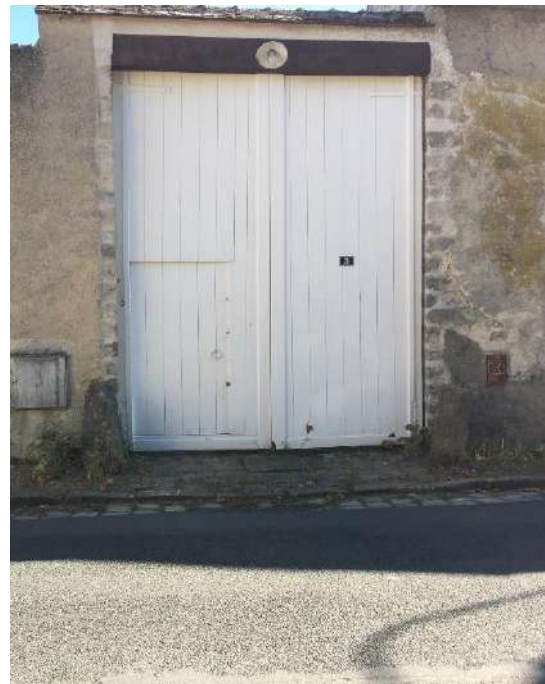
Figure 73 Exemple de deux chasse-roues rue de Nemours, 2018, © EG
