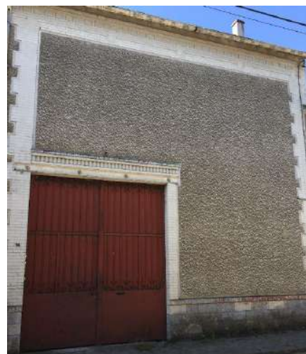
Figure 78 Façade d'une ferme rue René Lefevbre, 2018, © EG
