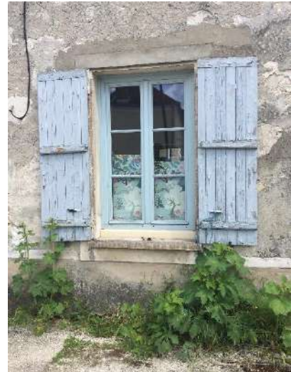
Figure 84 Baie à deux vantaux, rue de l'Eglise, 2018, © EG
