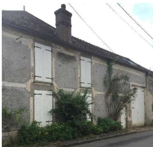
Figure 76 Exemple d'enduit couvrant, 2018, © EG
