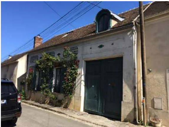
Figure 87 Exemple d'une lucarne demi-ronde avec une couverture arrondie, rue René Lefevbre, 2018, © EG
