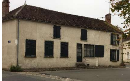
Figure 58 Maison Noret, octobre 2018, © EG
