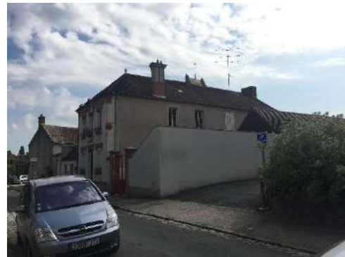
Figure 22 Vue de l'extension de l'école, 2018, © EG
