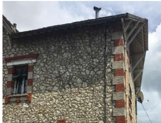
Figure 80 Exemples de toitures rue de l'Eglise, 2018, © EG
