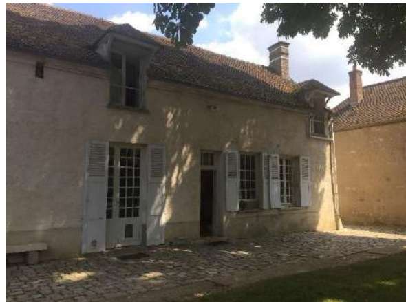
Figure 88 Exemple de gerbière rue Du Buisson, 2018, © EG
