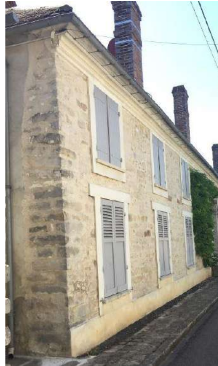
Figure 77 Façade d'une ancienne ferme rue Du Buisson, 2018, © EG
