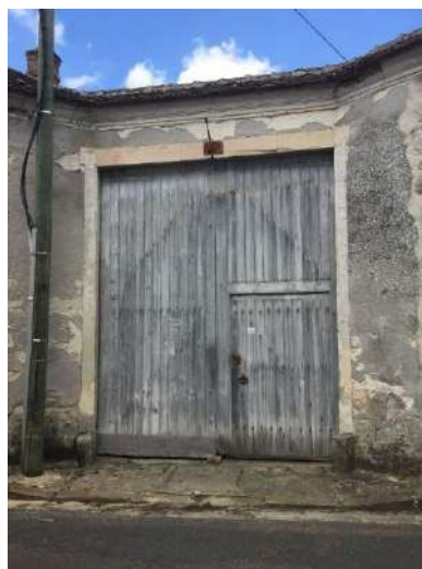
Figure 90 Exemple de porte charretière avec porte piétonne, rue de Nemours, 2018, © EG
