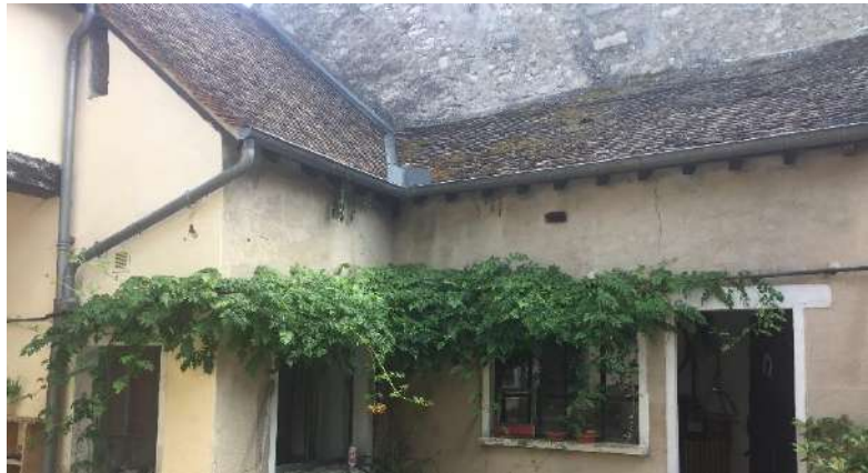
Figure 79 Exemple de toiture en tuiles plates rue Du Buisson, 2018, © EG
