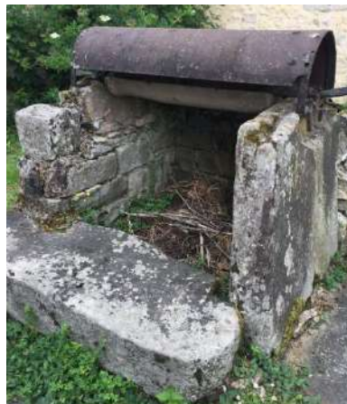
Figure 29 Puits en grès, 2018, © EG
