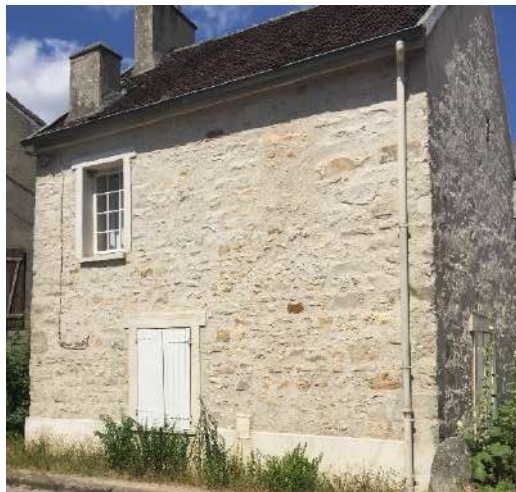
Figure 75 Exemple de mortier couleur sable, 2018, © EG
